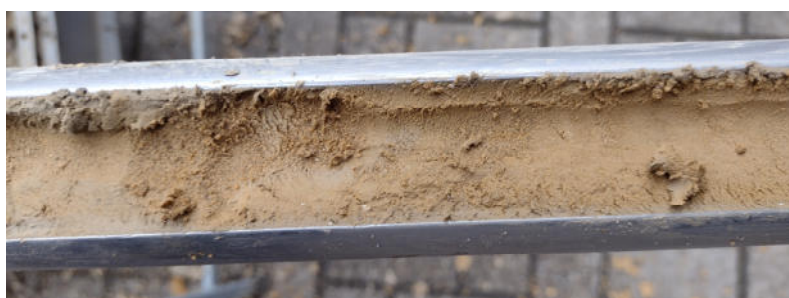
Abbildung 4: Abschwemmmassen (steif bis halbfest) - Kleinbohrung
