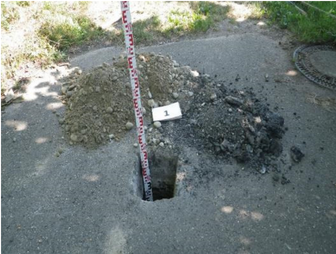
Foto 1: Aushub bei SCH 1
