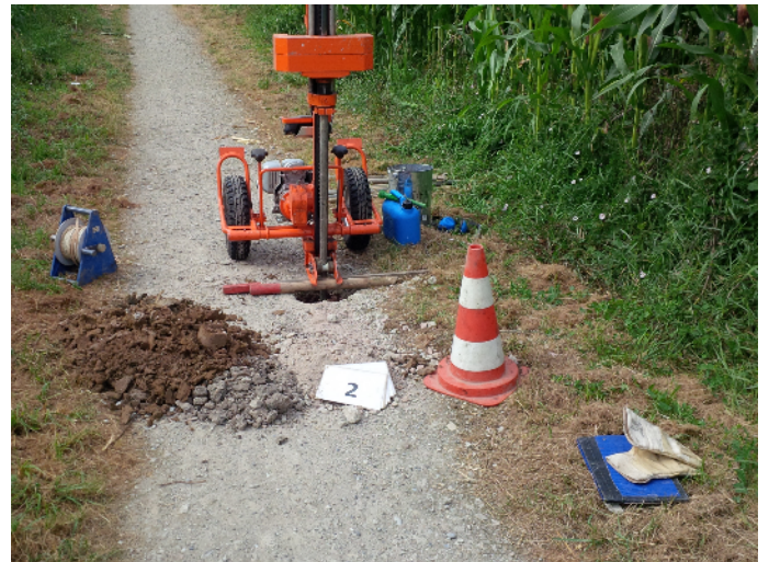
Foto 10: Aushub bei RKS 3 / DPH 2
