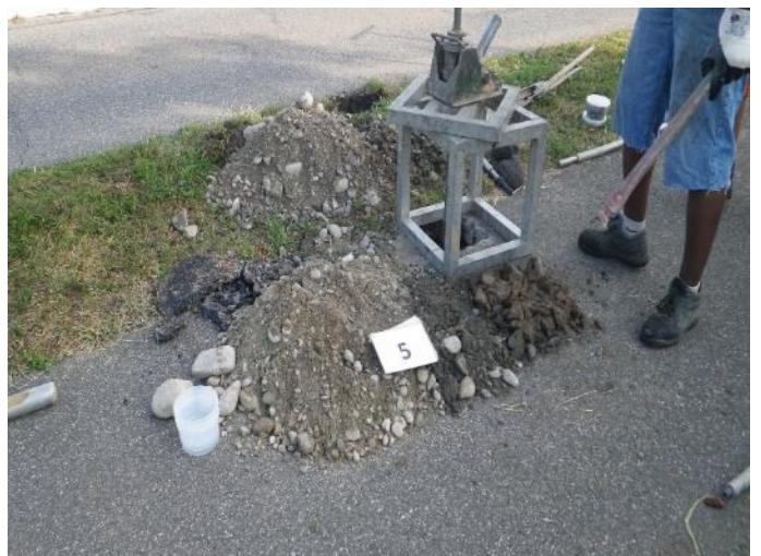
Foto 6: Aushub bei RKS 5 und SCH 3
