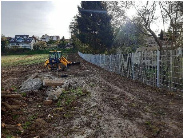
Gerodeter Gartenbereich im Plangebiet.
