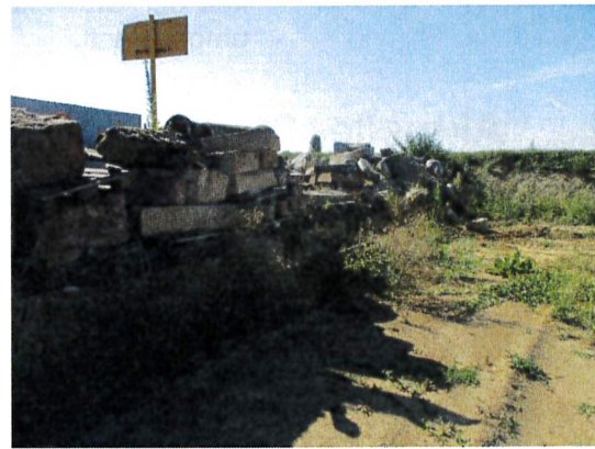
Abb. 4: Ehemaliger Erdwall, abgetragen. Foto: faktorgruen, 25.08.2022
